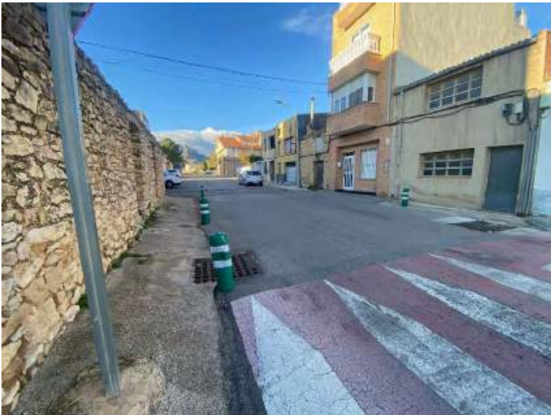
Imatge 4. Vista de l'edifici a enderrocar i pas de peatons elevat
