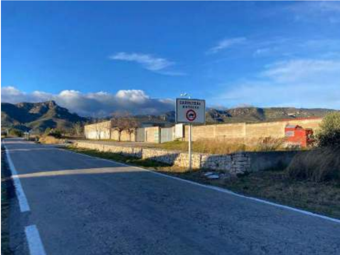
Imatge 7. Vista de l'entrada del magatzem de la brigada on s'instal·laran lluminàries
