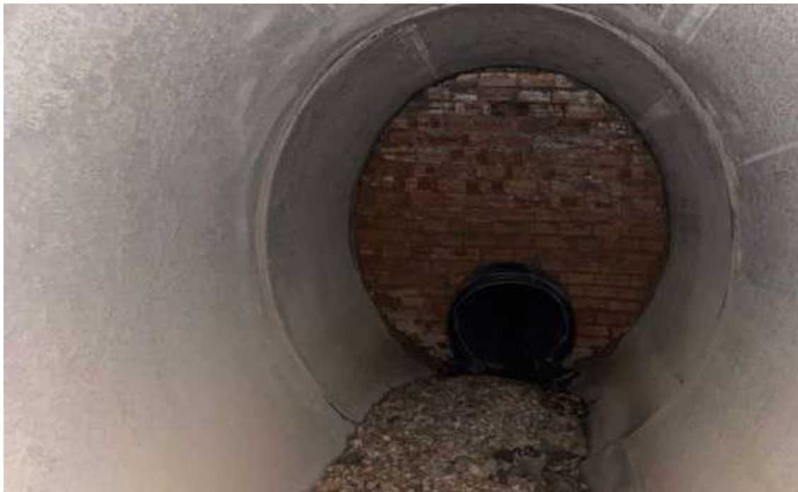
Imatge 3. Vista de la trobada entre el col·lector de pluvials antic (PP DN1000) i el nou (formigó DN2500). El nou està correctament dimensionat. S'observa el material sòlid arrossegat per la DANA i que es va dipositar en el fons.
