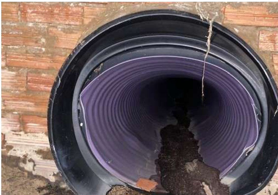
Imatge 4. Vista del col·lapse del col·lector antic que va provocar la inundació dels carrers que presta servei.
