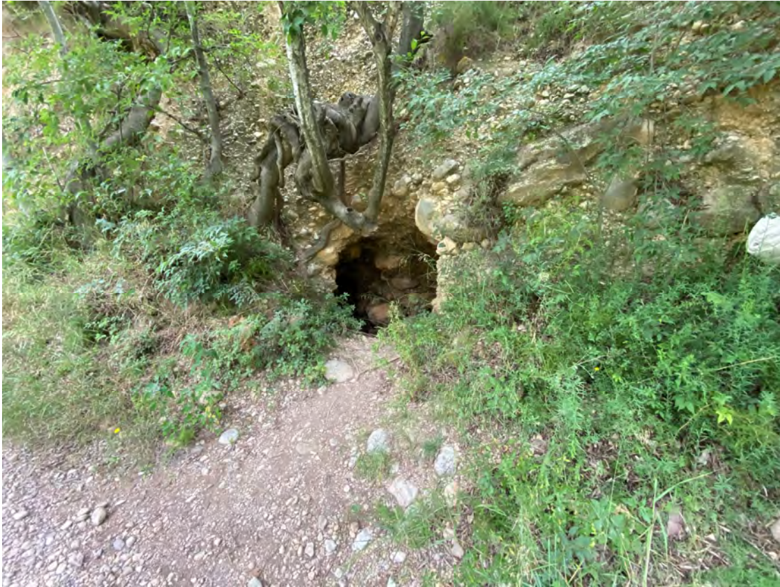
Imatge 13. Tancament galeria refugi quiropters
