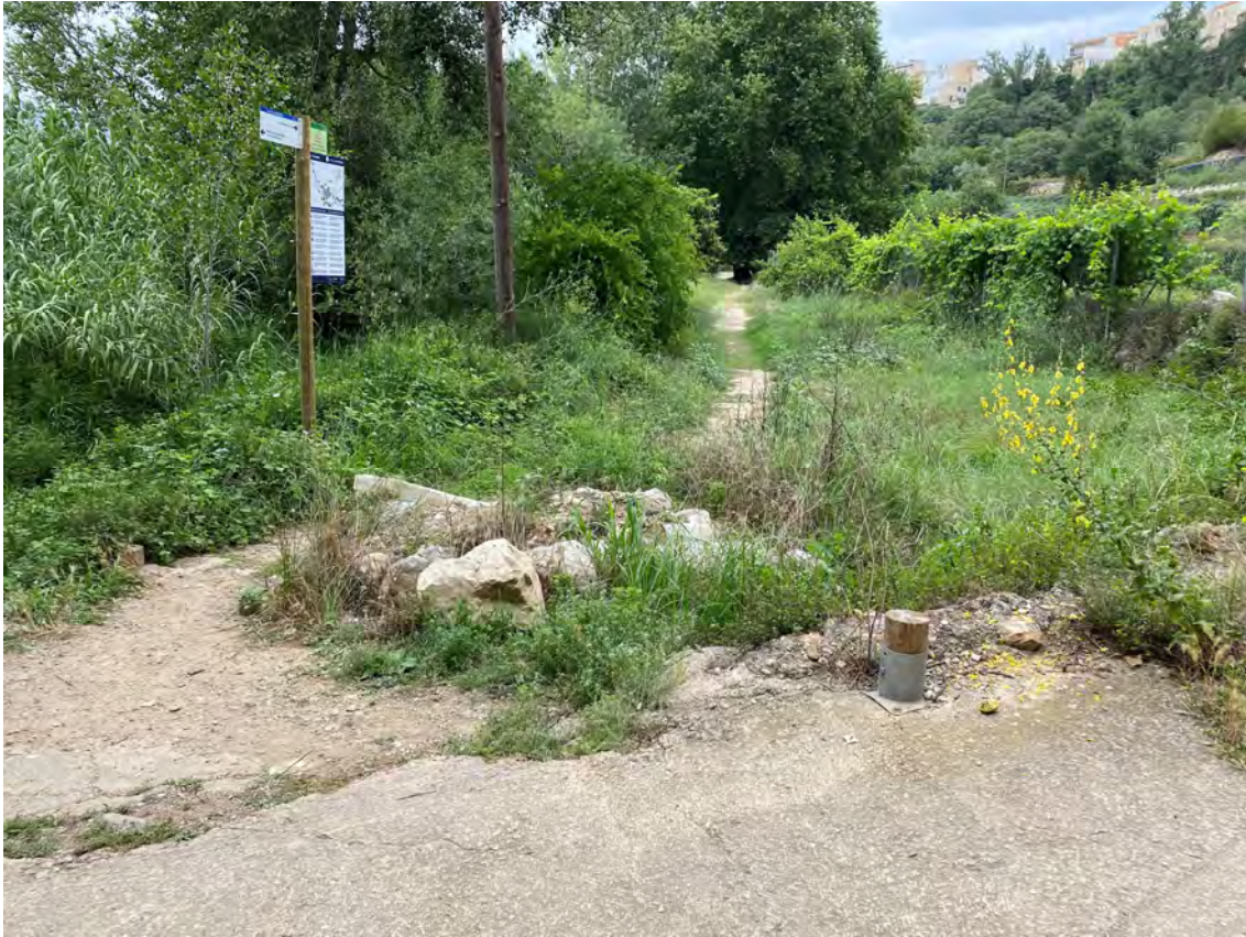
Imatge 9. Construcció barrera per al pas de vehicles
