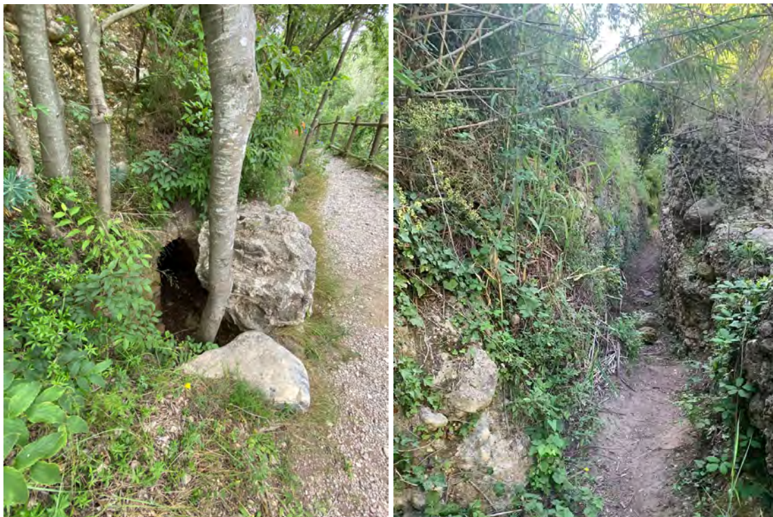
Imatge 12. Consolidació pas i tanca de la galeria per a refugi quiròpters
