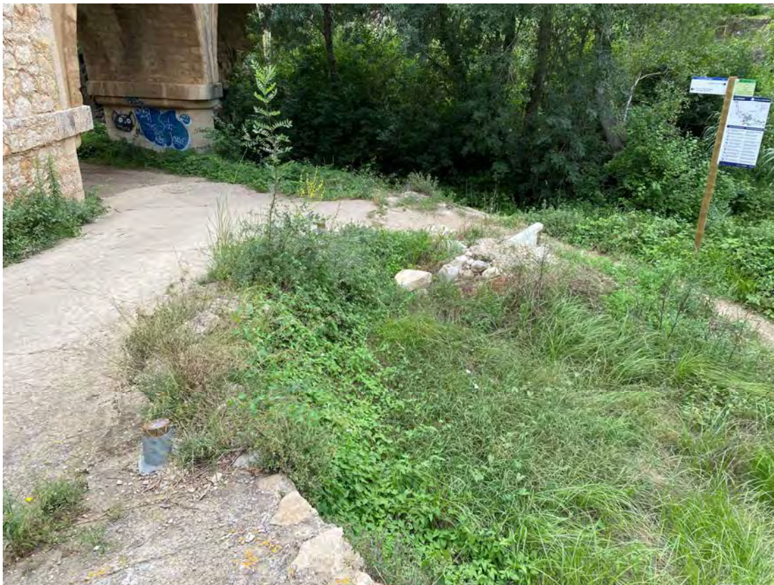
Imatge 8. Construcció barrera per al pas de vehicles
