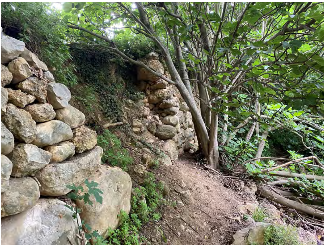
Imatge 15. Reconstrucció marge solsit zona tanca
